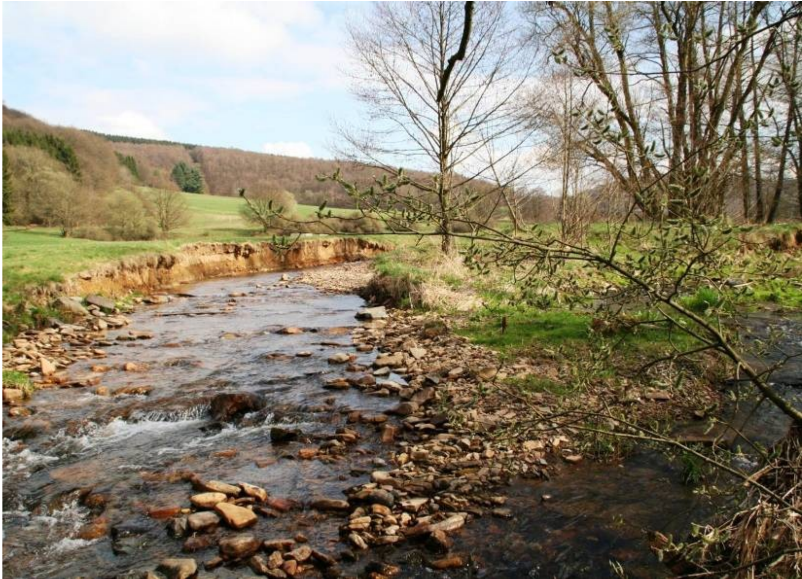
Beispiel für die Schaffung eines Zweitarms an der Heller in Burbach-Wahlbach
